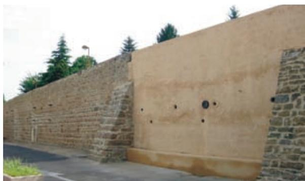
Le mur du parking situé sous la poste, près du cèdre, vient d'être enduit et ses joints ont été refaits afin de lui redonner une parfaite solidité et un meilleur aspect. Ces travaux sont réalisés et financés par le Grand Lyon ▶
